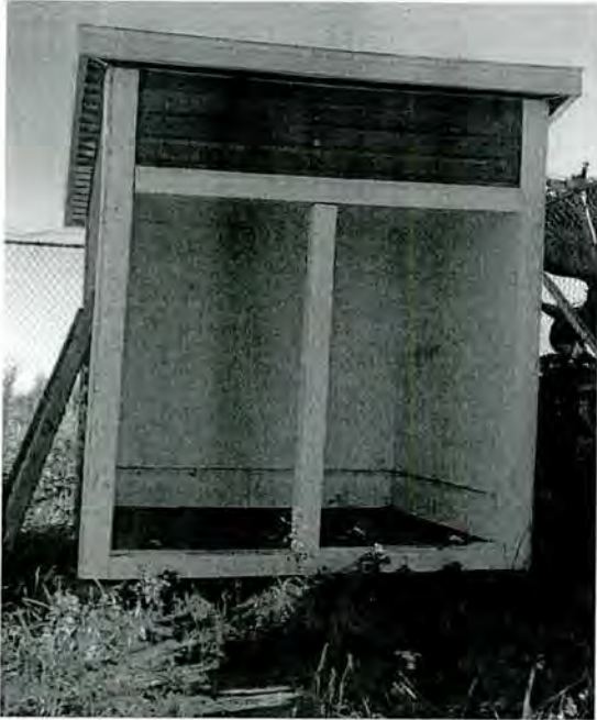
Photographie 42 : Futur lieu de stockage des batteries à Chevery (source : Pierre-Luc Dessureault)
